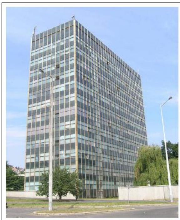
Obr. 1 Pohled na jihozápadní část Katedrového objektu MFF Univerzity Karlovy v areálu V Holešovičkách 2, Praha 8
