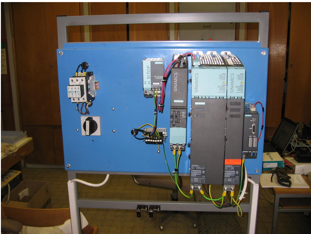
Obr. 13 Realizované vývojové pracoviště
