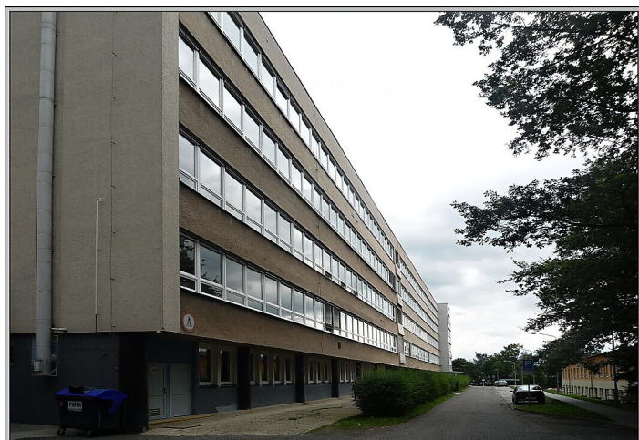
STAV PŘED REALIZACÍ - ISS Informatiky, elektrotechniky a řemesel Rožnov pod Radhoštěm
