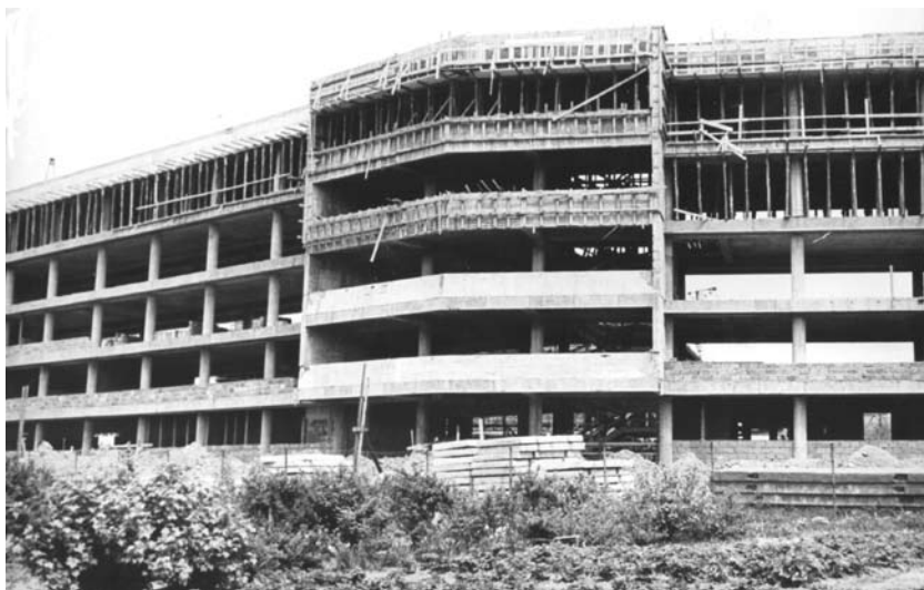
Rozestavěná nová školní budova
