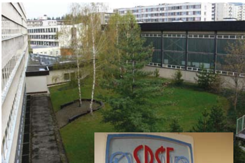
Pohled na atrium školy a sportovní areál SPŠE a SOU Rožnov pod Radhoštěm
