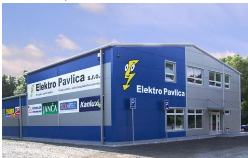
ELEKTRO Pavlica Rožnov pod Radhoštěm
